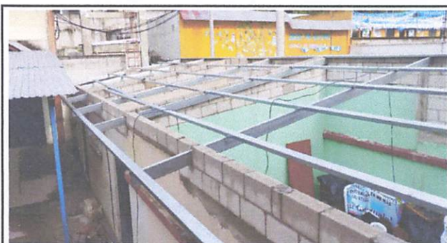
Foto 4: Techado bodega donde está la bomba de agua
