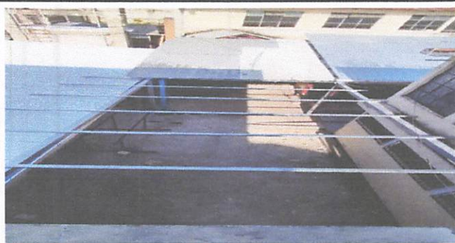
Foto1: Techado corredor frente a salón y bodega de Educación Física
