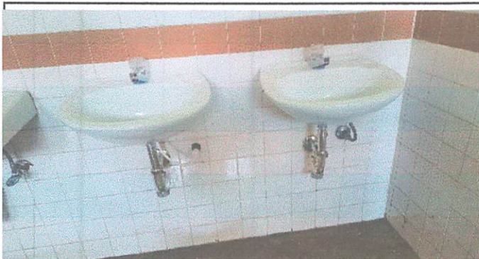
proceso finalizado de lavamanos
