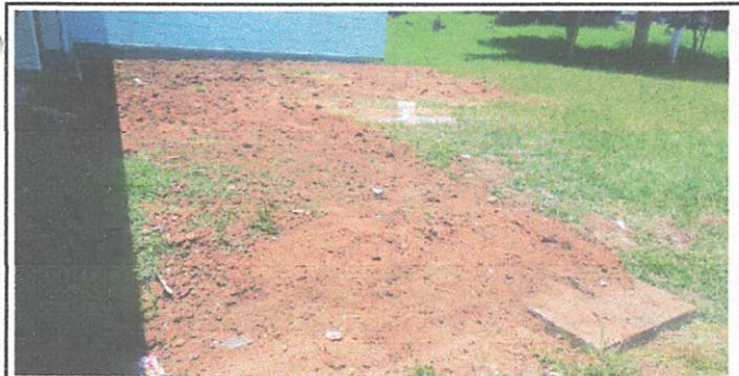
Tubería y drenaje teminado
