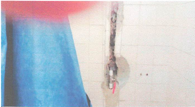
Proceso finalizado de llave de paso
