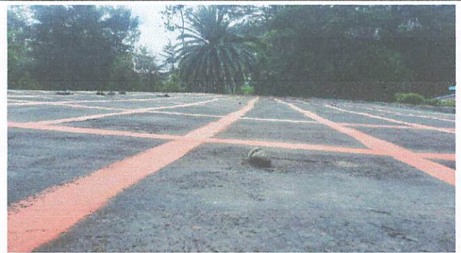
Impermeabilización en módulos
