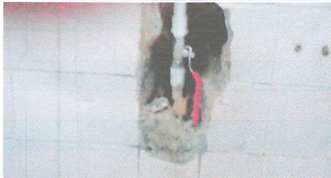
en proceso de cambio de llave de paso
