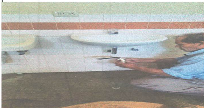
en proceso de la instalacion de lavamanos
