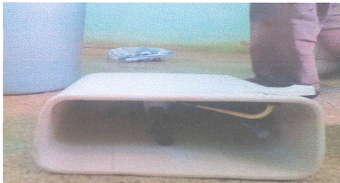
en proceso de cambio de accesorios de sanitario
