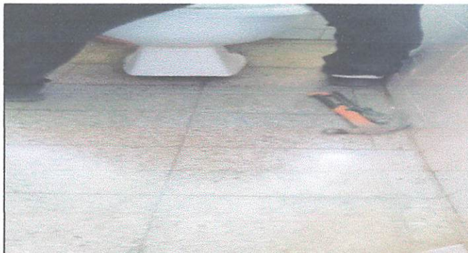
durante el cambio de sanitario
