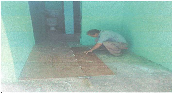
durante el proceso de cambio de piso
