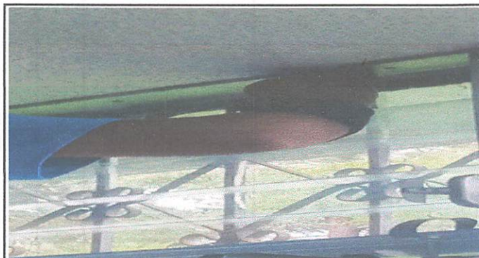
Durante el cambio de paletas de vidrio
