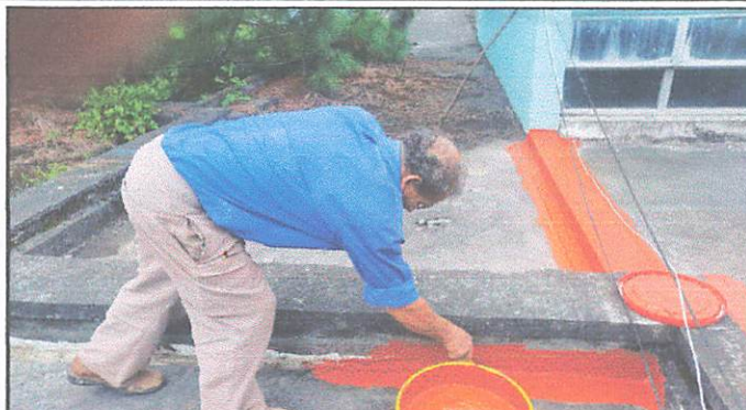
Durante la impermeabilización
