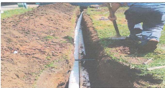
Durante el cambio de tubería en el drenaje
