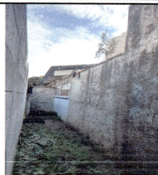
Foto 2: área de ampliación de cocina, lado atrás
