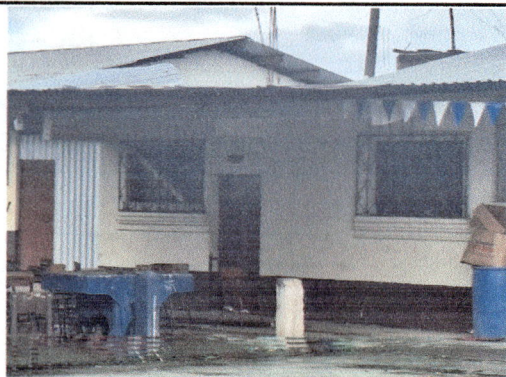
Foto1: Frente de la cocina
