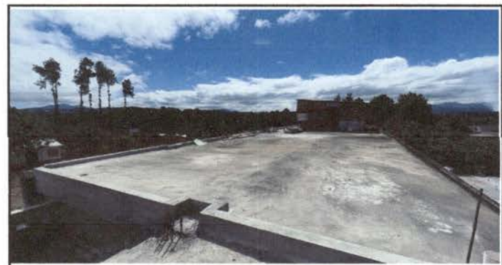
Foto 6: se necesita cernido en toda la orrila e implementar caída de agua para evitar estancamiento
