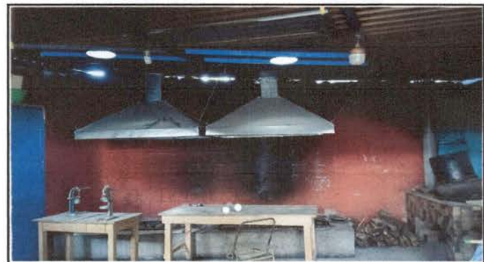
Foto 4: Implementación de campanas y extractores de humo
