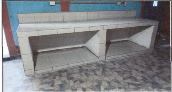
Foto 2: Adquisición de puerta y desayunoador con fundición de cemento
