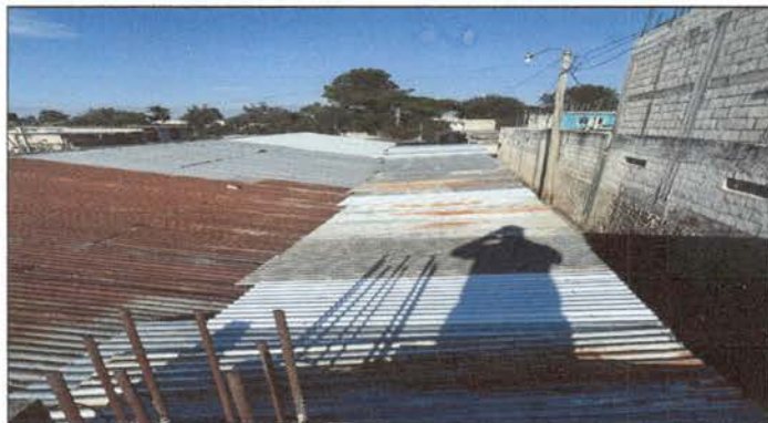
Foto 3: Implementación de techado en el corredor vacío
