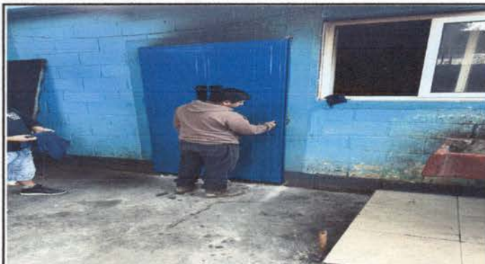
Foto 2: instalación de puerta
