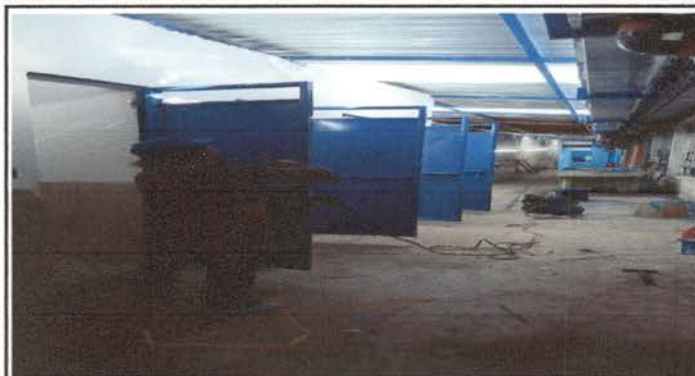
Foto 1: Culminación de servicios sanitarios
