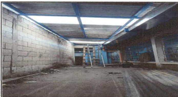
Foto 3: Implementación de techado en el corredor vacío
