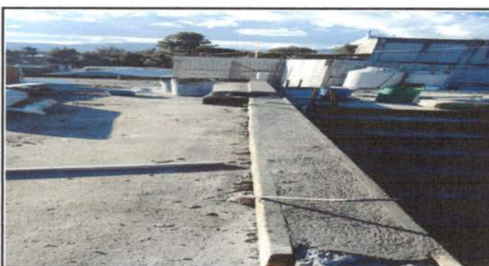
Foto 6: se necesita cernido en toda la orilla e implementar caída de agua para evitar estancamiento
