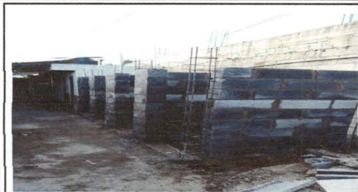
Foto1: Culminación de servicios sanitarios
