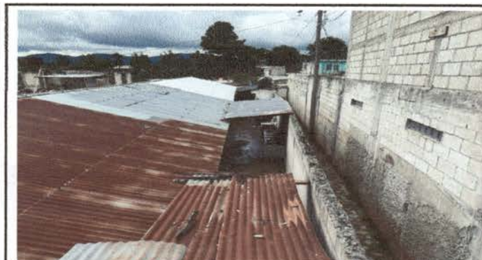
Foto 3: Implementación de techado en el corredor vacío
