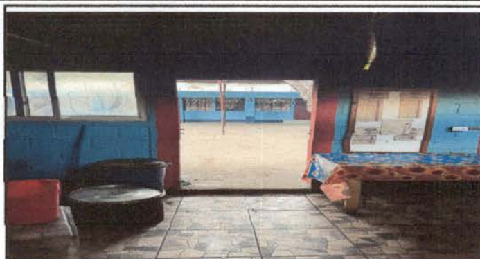
Foto 2: Adquisición de puerta y desayunoador con fundición de cemento
