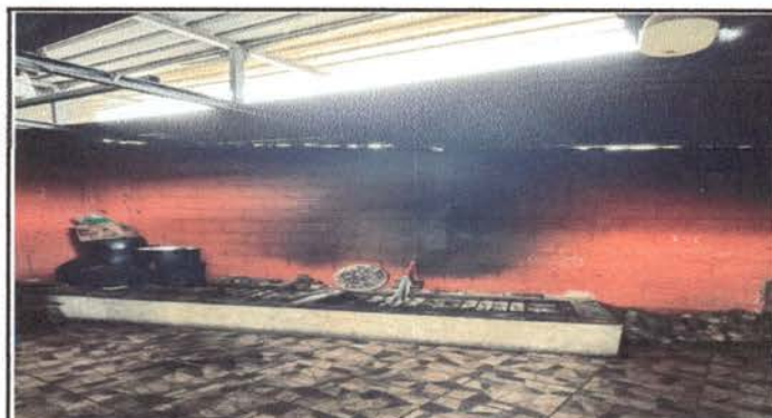
Foto 4: Implementación de campanas y extractores de humo
