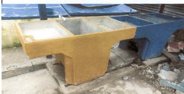
Foto 3: Piletas: Pileta instalada
