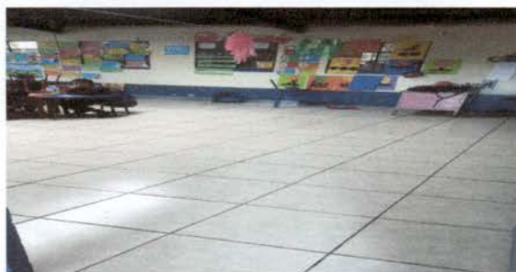
Foto 5: Salón Preparatoria B: Colocación de piso cerámico
