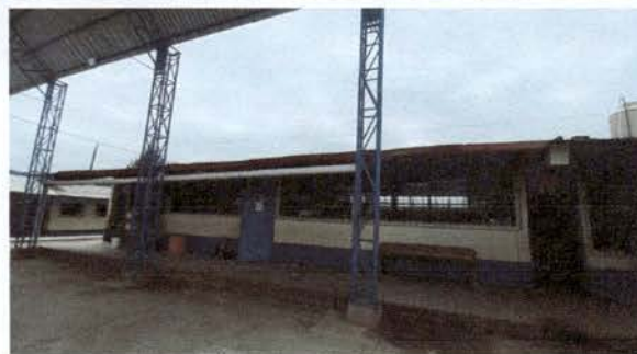
Foto 2: Cancha: Bajadas y canales instalados.
