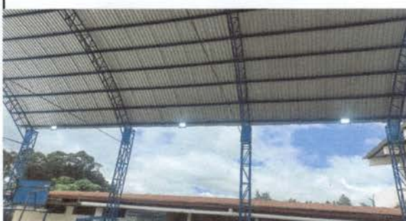
Foto 4: Techado: Reflectores instalados
