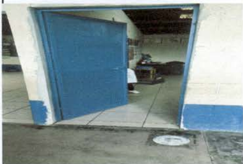
Foto 1: Salón Prepa A: Finalización de instalación de puerta.
