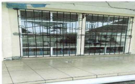
Foto 2: Salón Cuarto A: Colocación de dos balcones, finalizado
