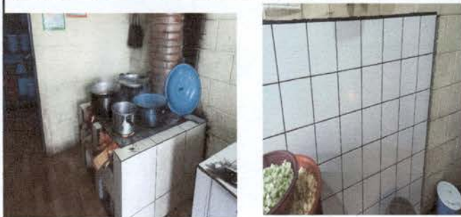
Foto 1: COCINA. Cambio de planchas y colocación de azulejo
