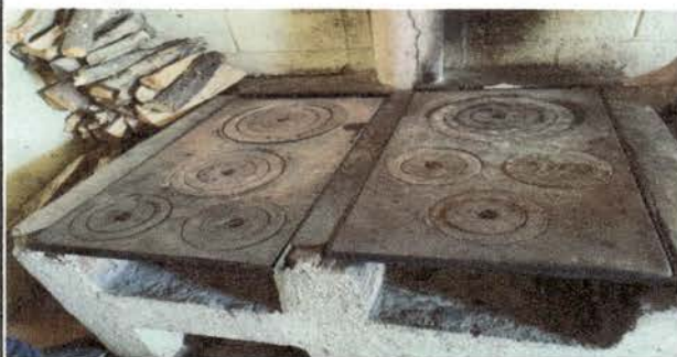
Foto 1: COCINA. Cambio de planchas y colocación de azulejo
