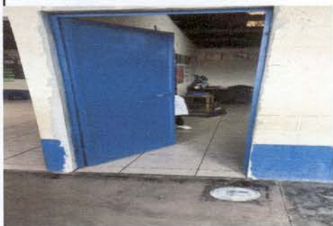
Foto 1: Salón Prepa A: Instalación de puerta.
