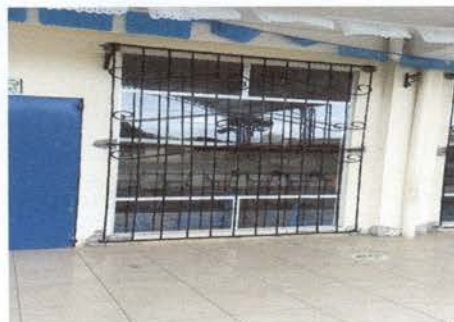
Foto 2: Salón Cuarto A: Colocación de balcon.
