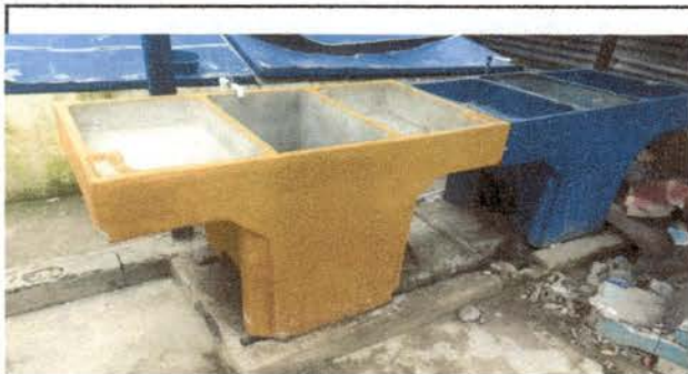
Foto 3: Piletas: Colocación de pileta
