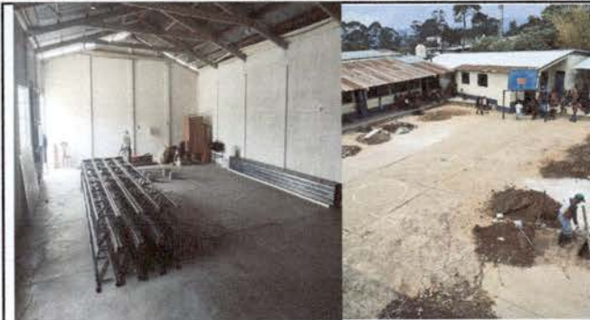
Foto 2: Cancha: alumbrado electrico, colocación de bajadas y canales.
