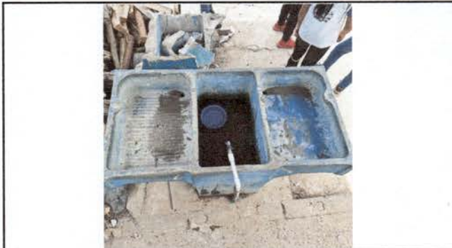
Foto 4: Pasillos de la escuela: cambio de pila.
