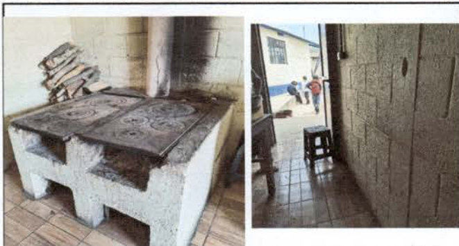
Foto 1: COCINA. Cambio de planchas, reparación de bases, cambio de chimenea y colocación de azulejo en paredes.
