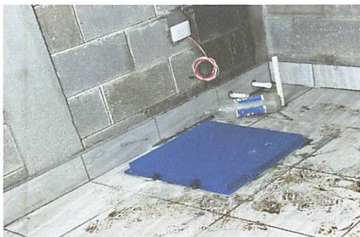
Foto 9: Instalación de Bomba eléctrica
