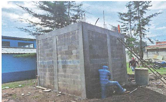
Foto 10: Realización de bodega de 3.00*3.00*3.03 metros
