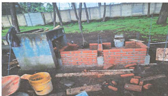
Foto 5: Elaboración de poyo para cocina principal. Ver acta de cambio de lugar.
