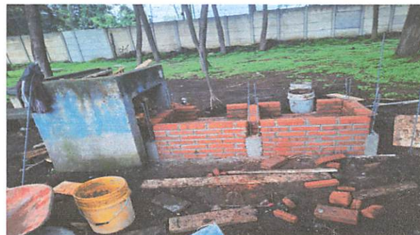
Foto 4: Elaboración de un poyo para cocina auxiliar. Ver acta de cambio de lugar.
