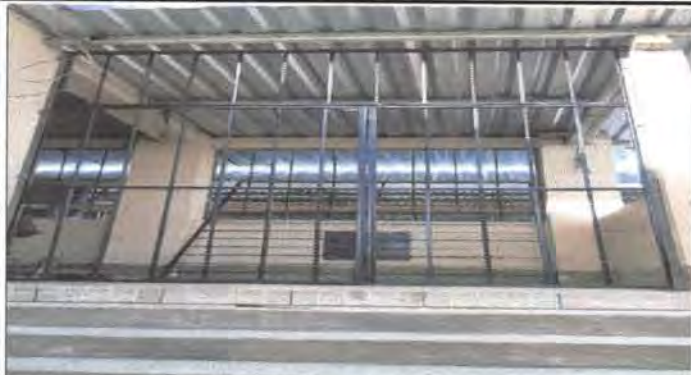
Foto1: PUERTA EN LAS GRADAS YA INSTALADA
