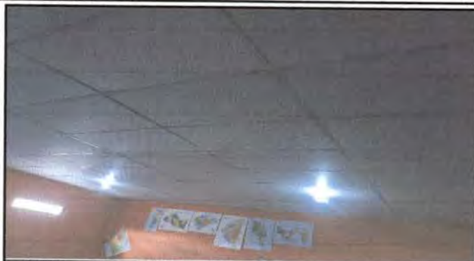
Foto 1: CIELO FALSO TERMINADO
