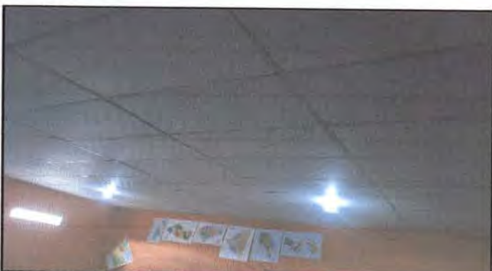
Foto 3: ILUMINACION DE AULAS TERMINADA
