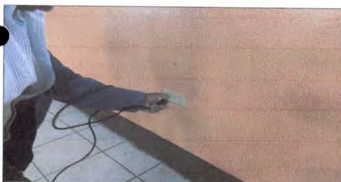
Foto 5: TOMACORRIENTES YA TERMINADO
