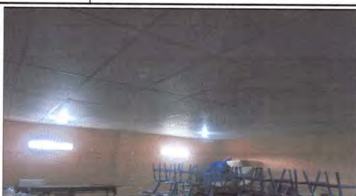
Foto 2: CIELO FALSO INSTALADO
