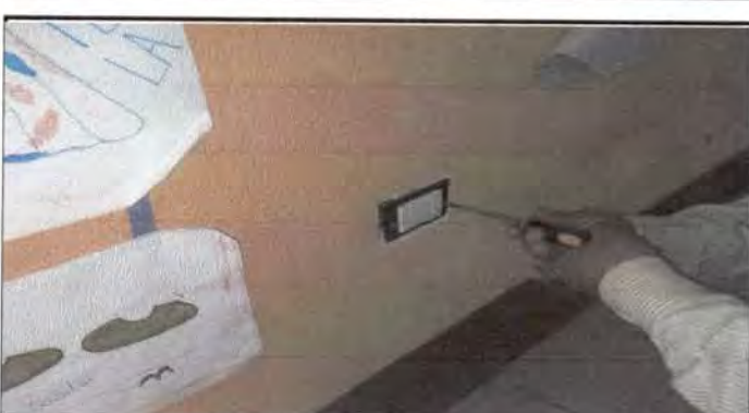
Foto 4: Instalación de toma corrientes
