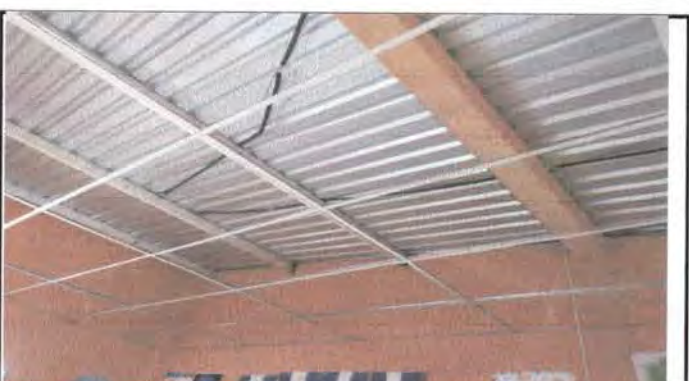
Foto 4: Iniciando la base para el cielo falso
