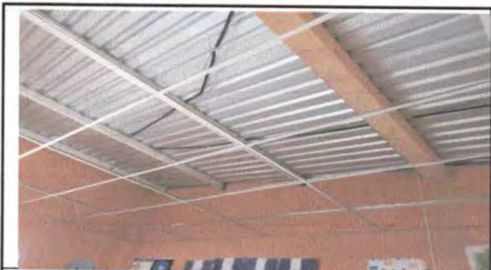
Foto 3: Instalación de esqueleto para el cielo falso
