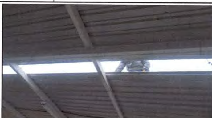
Foto 2: Instalación de techo
