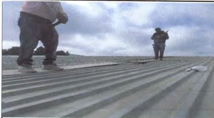
Foto 1: Instalación de lamina
