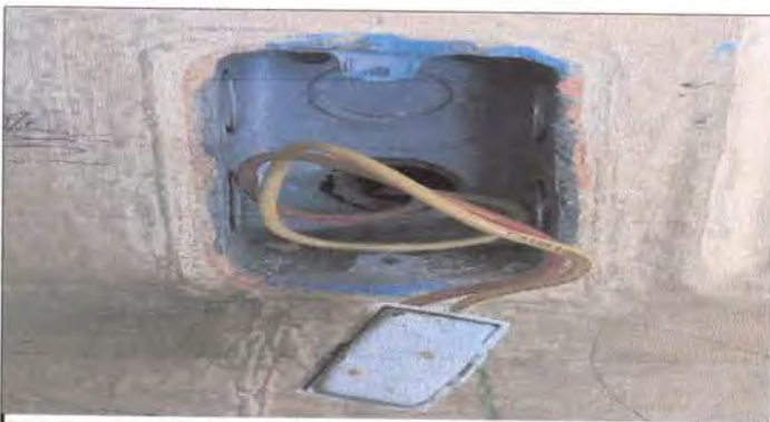
Foto 3: Instalación de tomacorriente
