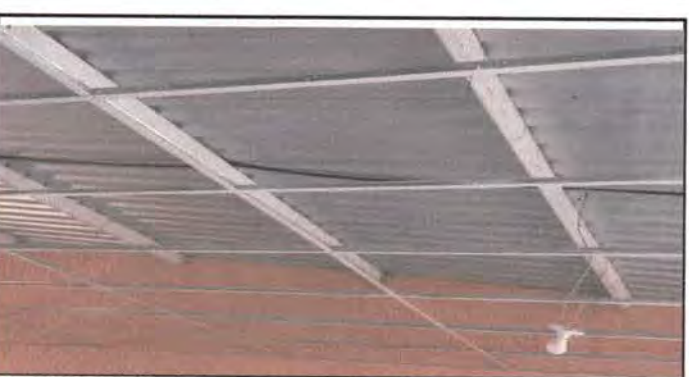
Foto 6: Instalación de los focos para la luz eléctrica.
