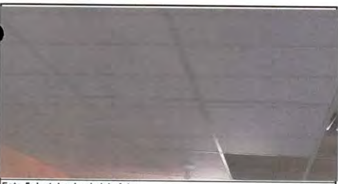
Foto 5: Instalando el cielo falso.
