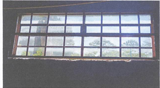
Foto 2: balcones para resguardo en cocina.
