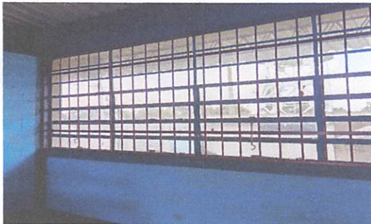
Foto 3: balcones en salones para resguardo de material y equipo.
