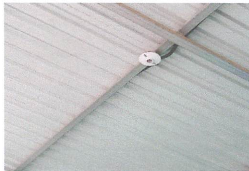
Foto 4: trabajo de iluminación durante.
