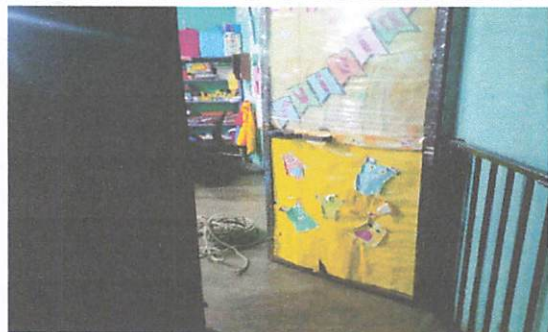
Foto 5: puertas que van a ser remozadas empezando a trabajarlas.
